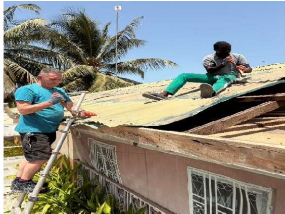
Verwijderen van oude golfplaten
